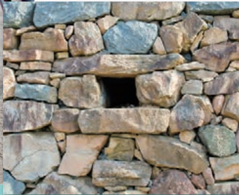
雨水が貯まらないように排水溝も備えられていた。
